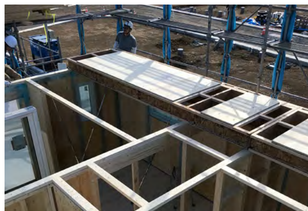
墜落・転落災害防止のために、2階床に合板付きの床パネルを採用（写真2）。
