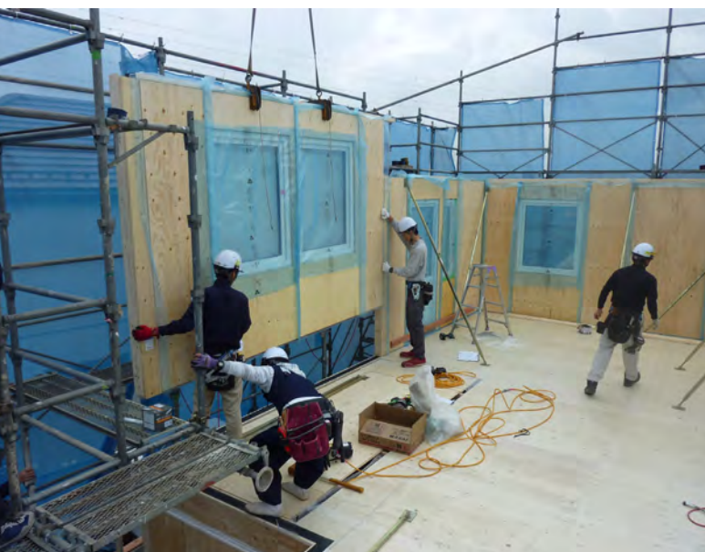
建築現場に最大幅3.6mの大型外壁パネルを搬入（写真1）。
