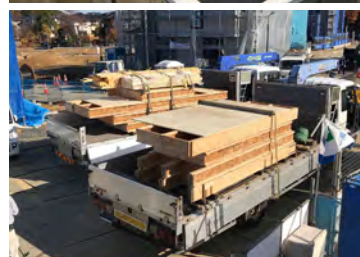
墜落・転落災害防止のために、2階床に合板付きの床パネルを採用（写真2）。
