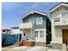
中川市宮久保分譲住宅
