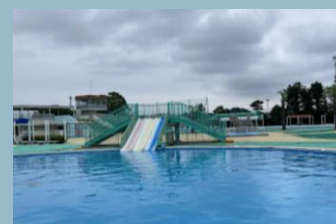
市川市市民プール
